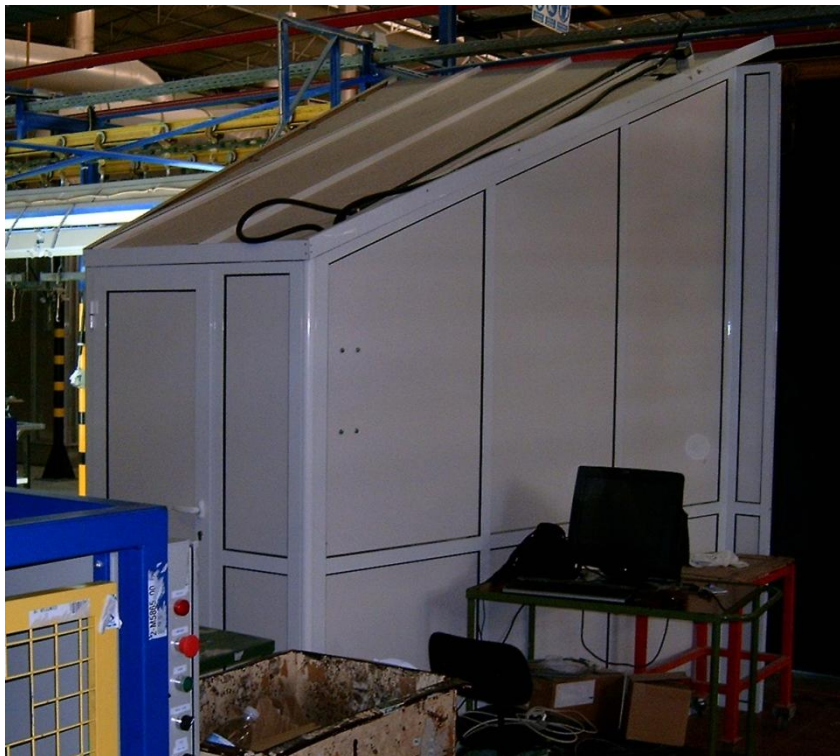
Fig. 101 - Aspecto exterior da cabine
